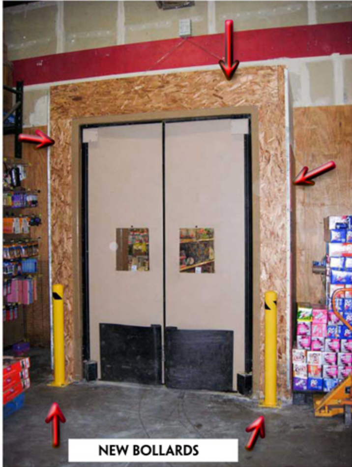
Door frame repaired
